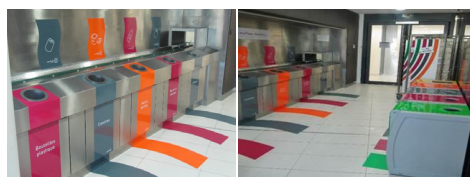
Bacs de tri placés le long du convoyeur de plateaux et en vis à vis pour fluidifier le passage des convives au moment de la dépose plateau.
